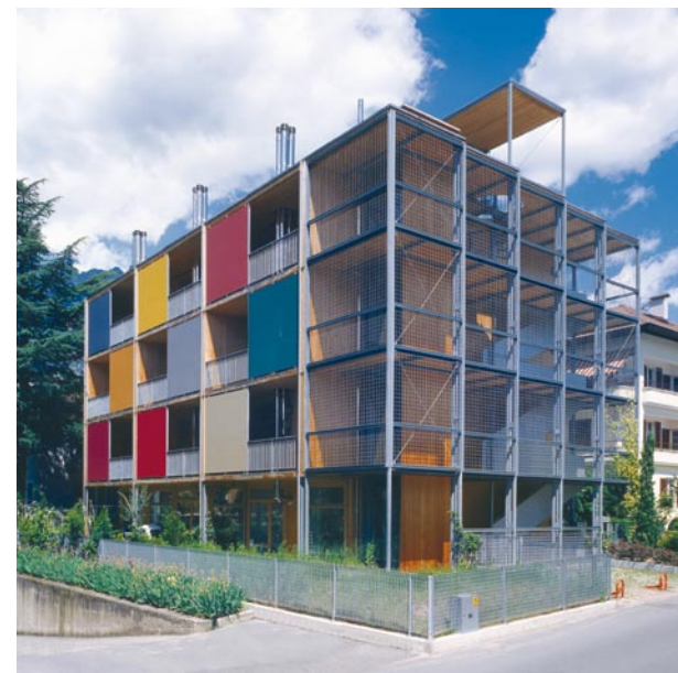
Natürlicher Sonnenschutz, KlimaHaus B, Kondominium in Meran
