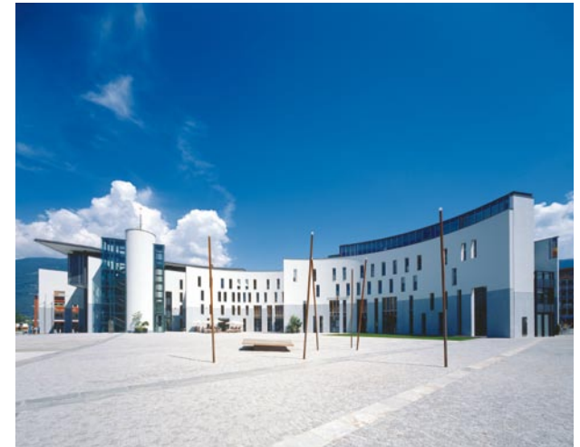
Anschluss am Biomasse-Fernheizkraftwerk, Rathaus Bruneck
