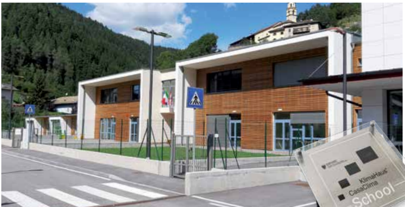
Schulgebäude/Scuola scolastico – Molina di Fiemme
